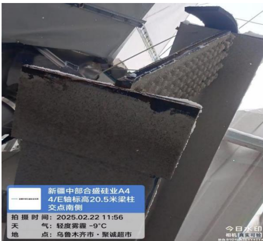
图 15 4/E 轴标高 20.5 米梁柱交点南侧
