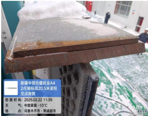
图 13 2/E 轴标高 20.5 米梁柱交点南侧
