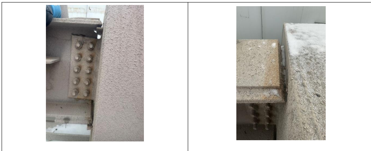
图 11 10/G 轴钢柱与 10/G~H 轴钢梁节点
