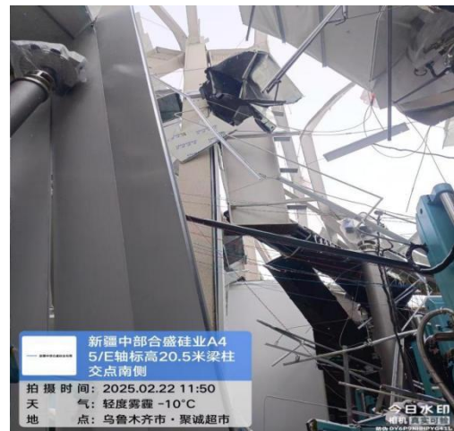
图 16 5/E 轴标高 20.5 米梁柱交点南侧
