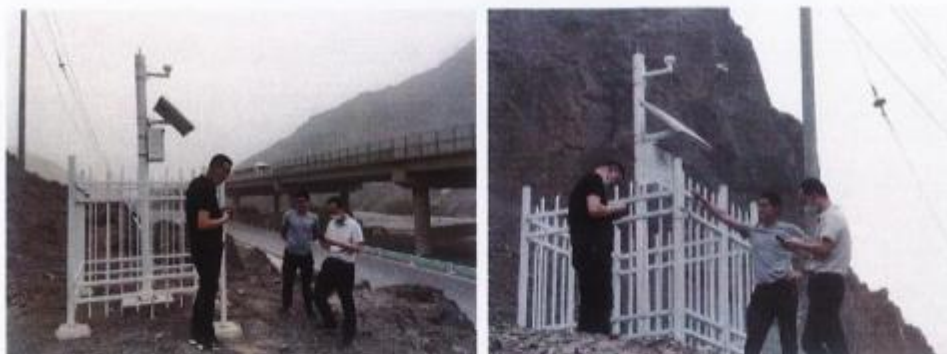
后沟国道 312 线 106.1km 处崩塌点现场培训
