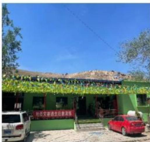
石仁子沟西岸滑坡
