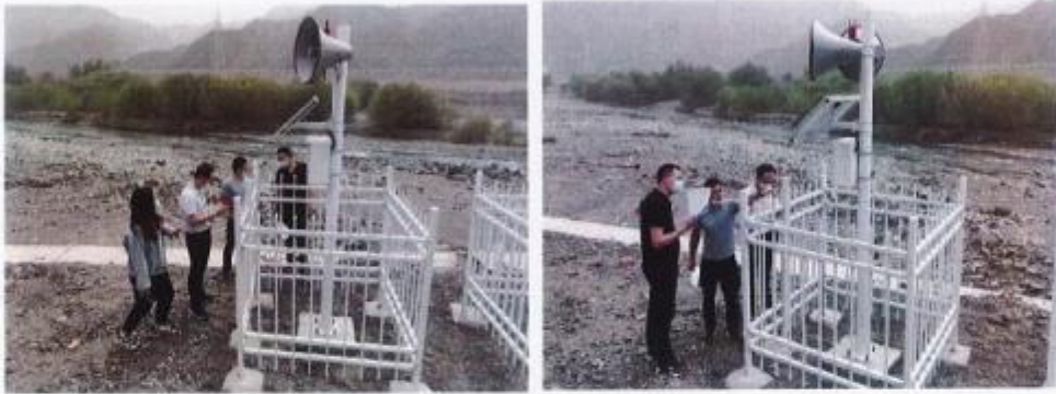
后沟国道 312 线 96km 处崩塌点现场培训
