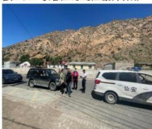
葛家村 2 队蝴蝶沟沟口崩塌
